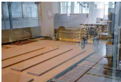
Ganz links: Im Reinigungsautomaten werden die Frontteile staubfrei gesäubert. Links: Der Auftrag des Klebstoffs (PUD) findet in einer Spritzkabine statt
